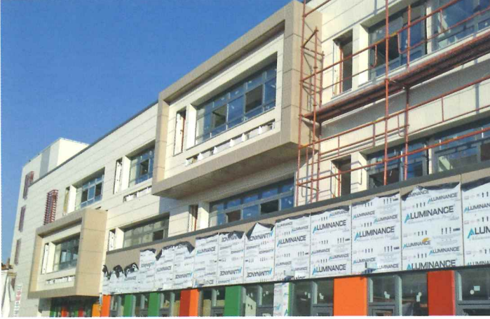
Okul Binası Giriş Cephesi – Sınıf, Pencere Altı Havalandırma Cihazı Menfezleri
